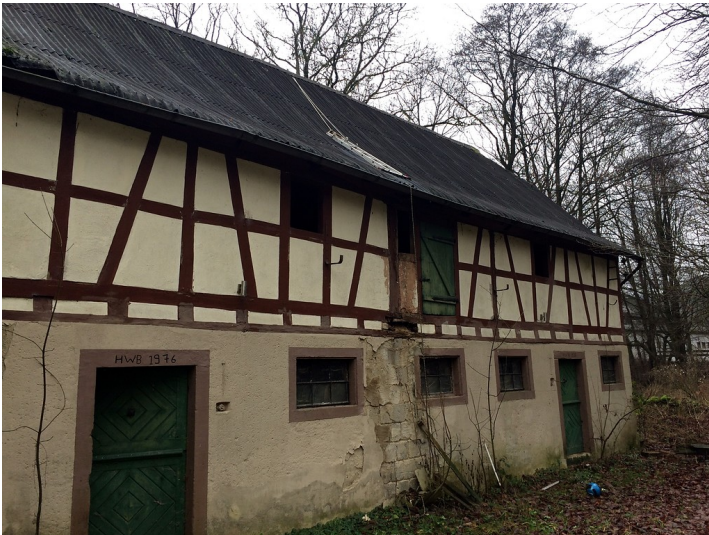
Scheunen der ehemaligen Eisenhütte in Abentheuer (2015) Fotograf/Urheber: Nicole Etzorn
