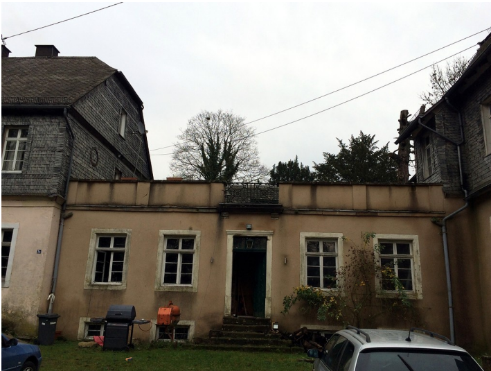
Zwischenhaus des Herren- und Gästehauses der Eisenhütte in Abentheuer (2015) Fotograf/Urheber: Nicole Etzorn
