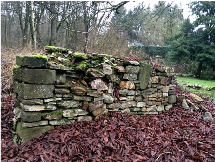
Mauerreste des Verwaltungsgebäudes der Eisenhütte Abentheuer (2015) Fotograf/Urheber: Nicole Etzorn
