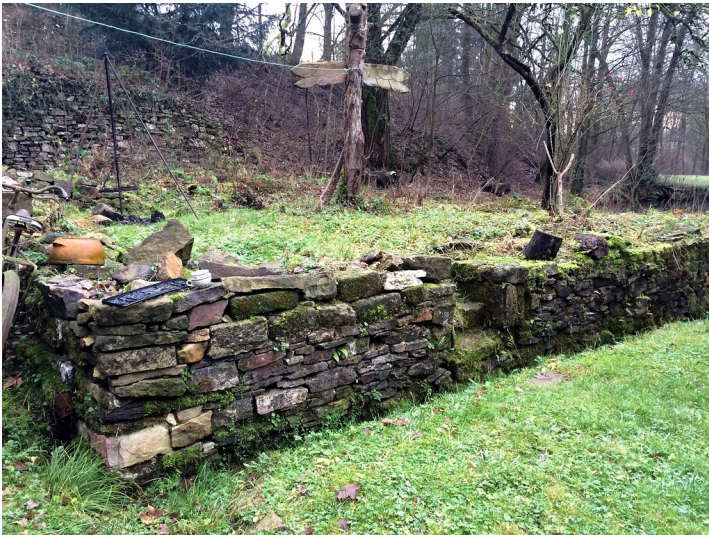
Ruine der Schmiede der Eisenhütte Abentheuer (2015) Fotograf/Urheber: Nicole Etkorn
