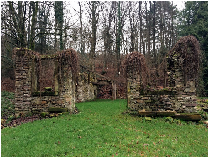
Ruine der Eisenschneide der ehemaligen Eisenhütte Abentheuer (2015) Fotograf/Urheber: Nicole Etkorn
