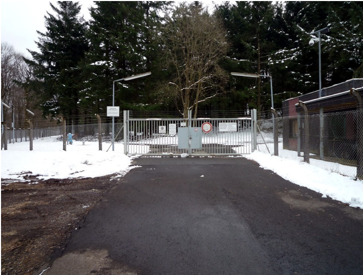
Toranlage des Militärgebäudes mit Funkturm am Ruppelstein (bzw. Ruppenstein) bei Börfink im Februar 2016. Fotograf/Urheber: Kira Bublies
