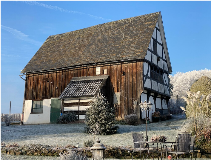
Scheuer Frohnhausen 1 in Hückeswagen (2022) Fotograf/Urheber: Dietfried Auras
