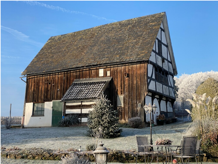
Scheuer Frohnhausen 1 in Hückeswagen (2022) Fotograf/Urheber: Dietfried Auras
