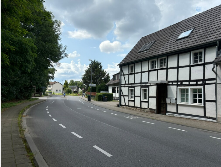
historische Bebauung an der Lützerathstraße (2024) Fotograf/Urheber: Carolin Ehret
