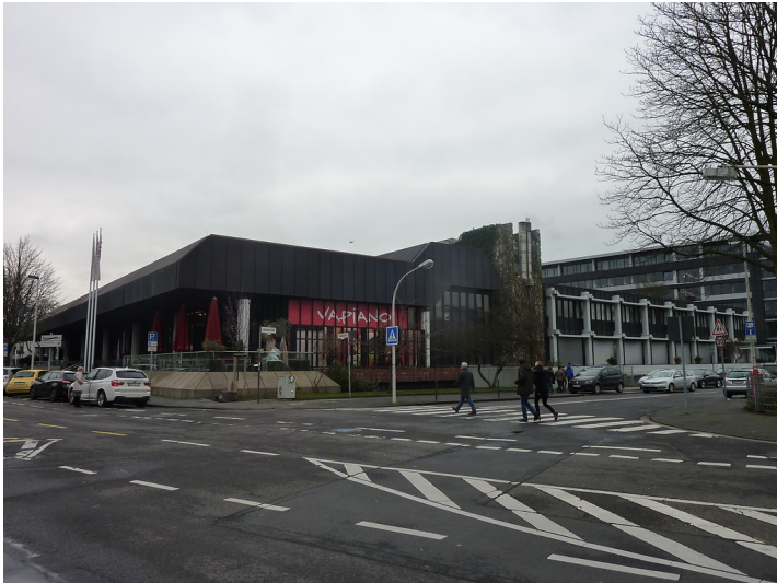
Die ehemalige SPD-Parteizentrale in Bonn, das Erich-Ollenhauer-Haus in der Ollenhauerstraße (2015).
