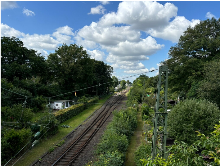
Eisenbahnstrecke Köln-Mülheim - Bergisch Gladbach (2024) Fotograf/Urheber: Carolin Ehret
