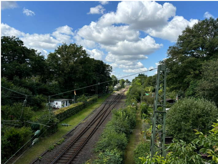
Eisenbahnstrecke Köln-Mülheim - Bergisch Gladbach (2024) Fotograf/Urheber: Carolin Ehret
