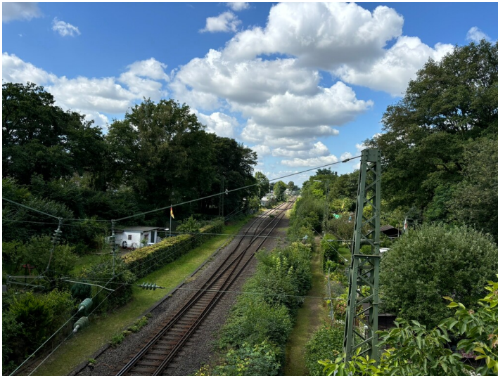
Eisenbahnstrecke Köln-Mülheim - Bergisch Gladbach (2024) Fotograf/Urheber: Carolin Ehret
