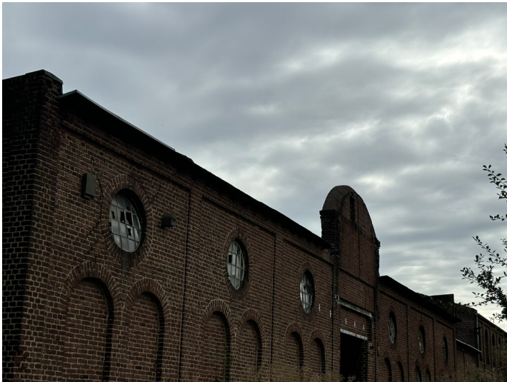
Fabrikgelände des Unternehmens CordierSpezialpapier GmbH auf dem ehemaligen Gelände der Schweinheimer Mühle (2024) Fotograf/Urheber: Carolin Ehret
