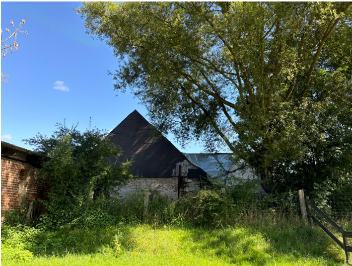
Thurner Mühle in Dellbrück (2024) Fotograf/Urheber: Carolin Ehret
