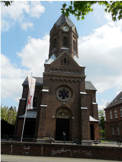
St. Cornelius Pfarrkirche in Köln-Heumar mit Blick auf den Haupteingang und den Turm (2015)
