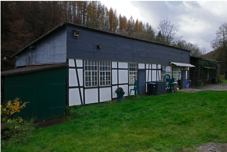
Untenrüdener Kotten in Solingen (2023) Fotograf/Urheber: Karl Peter Wiemer
