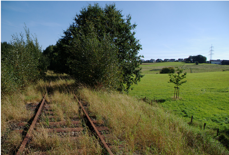
Schienen der Bahnlinie Wipperfürth - Lennep bei Busenbach (2007) Fotograf/Urheber: Attermeyer, Adolf
