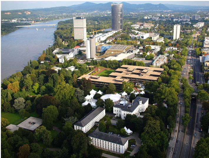
Luftbildaufnahme: Das frühere Regierungsviertel in Bonn zwischen Rhein und Adenauerallee / Willy-Brandt-Allee. Vorne ist das Palais Schaumburg mit dem dahinter liegenden früheren Bundeskanzleramt und den Bundestagsgebäuden zu sehen, dahinter das frühere Abgeordnetenwohnhaus "Langer Eugen" und der Post Tower vor dem Hintergrund des Siebengebirges (2010). Fotograf/Urheber: Wolkenkratzer
