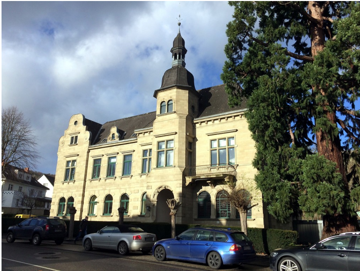
Frontansicht des sogenannten Altbaus der Kreisverwaltung Ahrweiler (2018), ehemaliges Landratsamt. Fotograf/Urheber: Elmar Knieps
