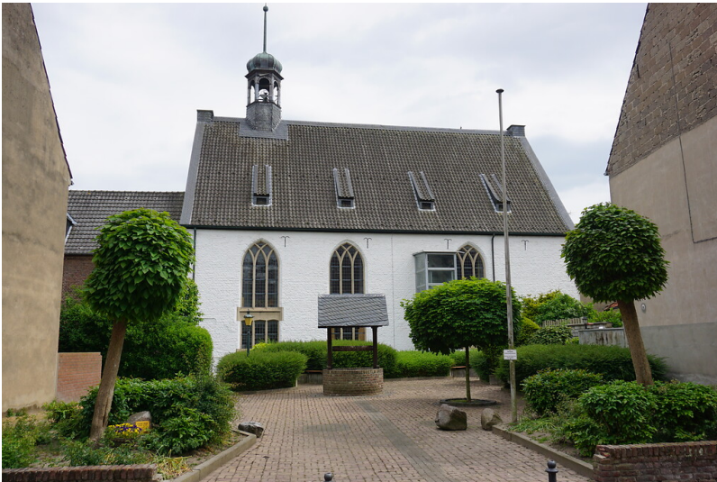
Rees, evangelische Kirche (2020), Blick von Nordwesten Fotograf/Urheber: Claus Weber
