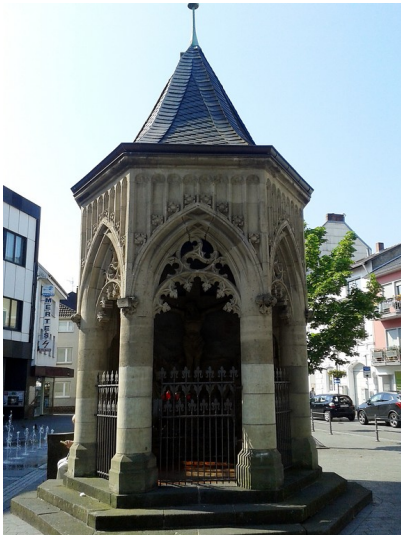
Kapelle am Alten Markt Bad Neuenahr (2016), Ansicht von Norden.
