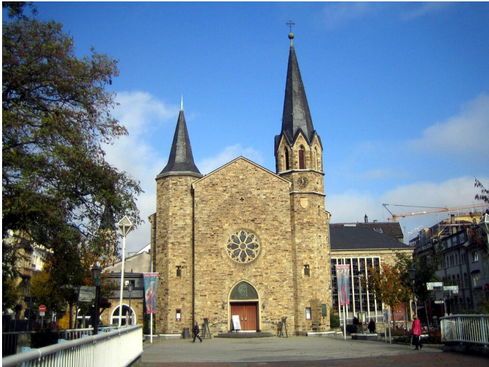
Martin-Luther Kirche in Bad Neuenahr (2015) Fotograf/Urheber: Vanessa Bindarra
