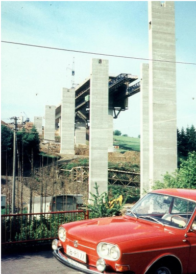
Historische Aufnahme aus den frühen 1970er Jahren mit Blick auf die Fertigstellung der Fahrbahn über den Pfeilern der Loopetalbrücke.
