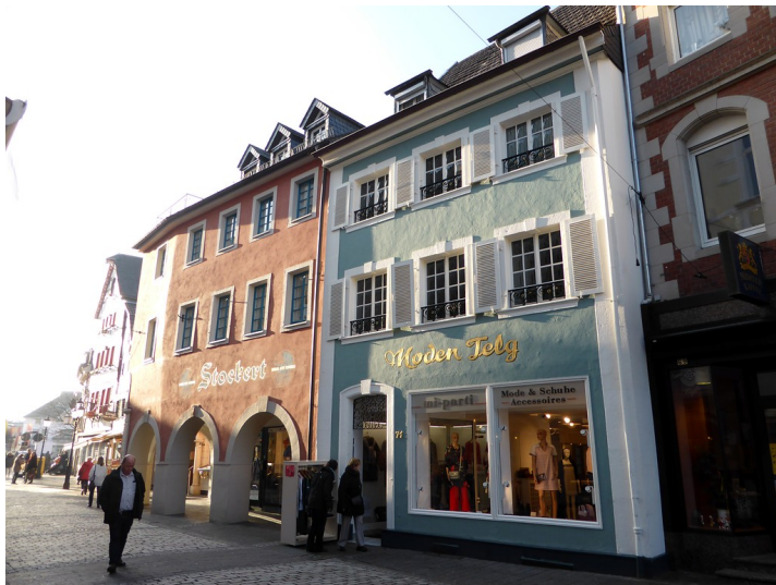
Haus Geschier in Ahrweiler (2018) Fotograf/Urheber: Elmar Knieps
