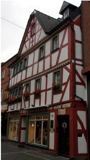
Haus Heinrichs in Ahrweiler (2015), Gesamtansicht von Osten. Fotograf/Urheber: Simone Jakobi
