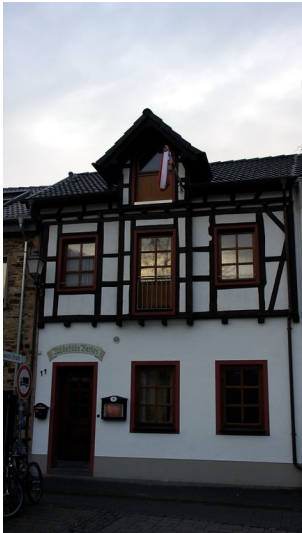
Backhaus der Niederhut in Ahrweiler (2016) Fotograf/Urheber: Simone Jakobi
