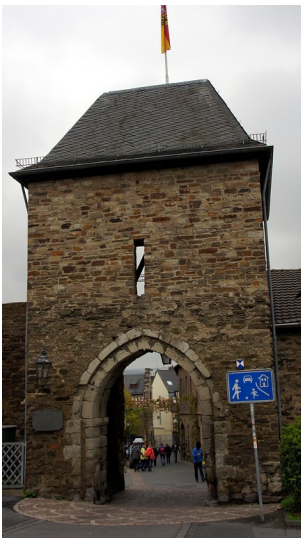
Außenansicht des Adenbachtors in Ahrweiler (2015) Fotograf/Urheber: Simone Jakobi
