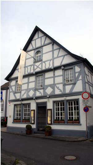
Außenansicht des alten Zunfthauses in Ahrweiler (2015) Fotograf/Urheber: Simone Jakobi
