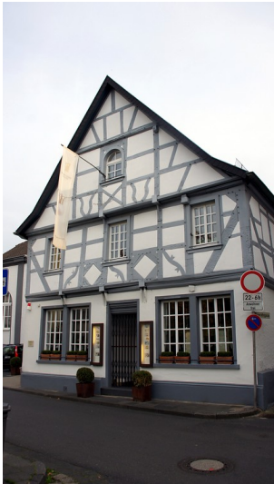
Außenansicht des alten Zunfthauses in Ahrweiler (2015) Fotograf/Urheber: Simone Jakobi
