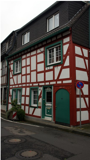
Haus Thies in Ahrweiler (2015) Fotograf/Urheber: Simone Jakobi
