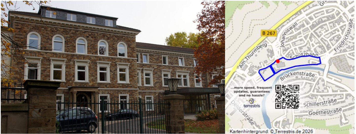
Frontansicht des Hauptgebäudes der Dr. von Ehrenwall'sche Klinik Ahrweiler (2015). Fotograf/Urheber: Simone Jakobi
