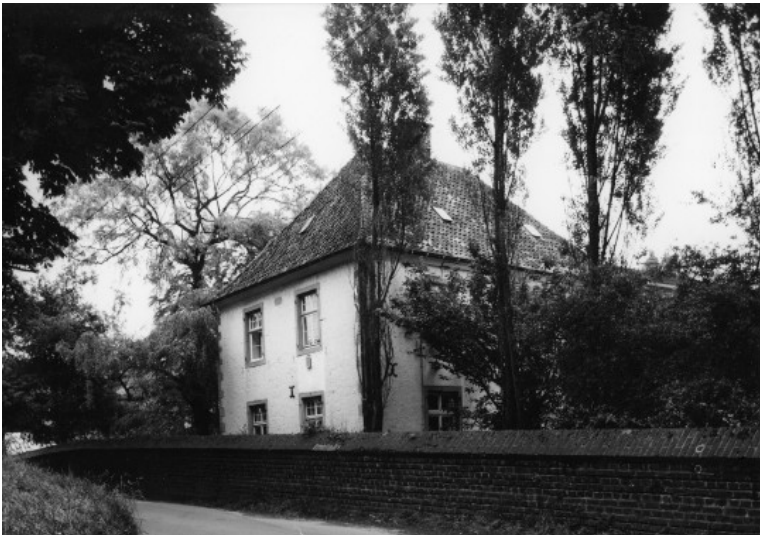
Haus Düssel in Wülfrath-Düssel (1978) Fotograf/Urheber: Frances Sturm
