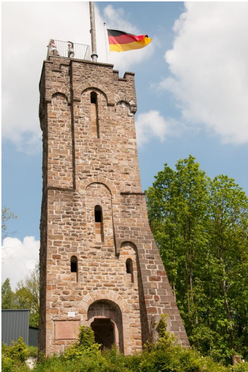
Blick aus südlicher Richtung auf den Haldyturm in Runderoth (2010) Fotograf/Urheber: Frank Herhaus
