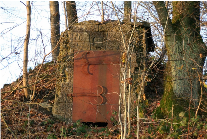
Pumpenhäuschen der ehemaligen Wasserversorgung von Morsbach Hülstert (2013)
