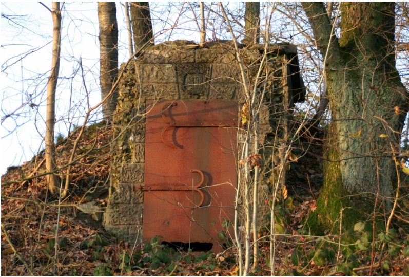
Pumpenhäuschen der ehemaligen Wasserversorgung von Morsbach Hülstert (2013)
