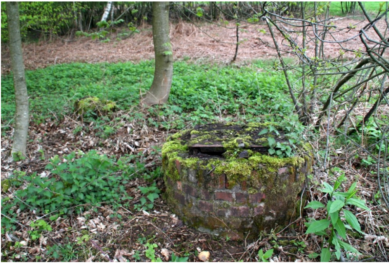
Quellfassung der alten Lichtenberger Wasserversorgung in Morsbach-Lichtenberg (2012)
