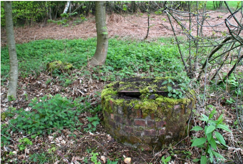
Quellfassung der alten Lichtenberger Wasserversorgung in Morsbach-Lichtenberg (2012)
