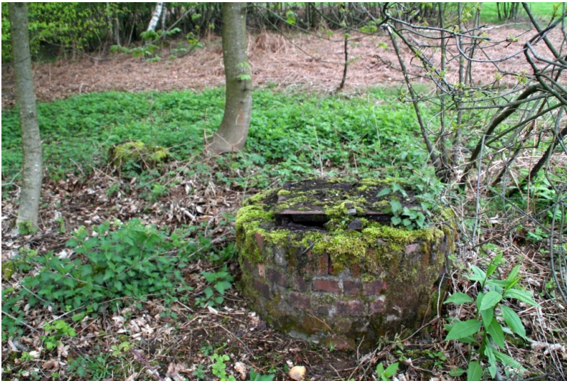
Quellfassung der alten Lichtenberger Wasserversorgung in Morsbach-Lichtenberg (2012)
