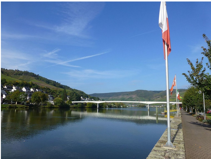
Blick auf die Straßenbrücke über die Mosel zwischen der Stadt Zell und dem Ortsteil Kaimt (2010) Fotograf/Urheber: giggerl
