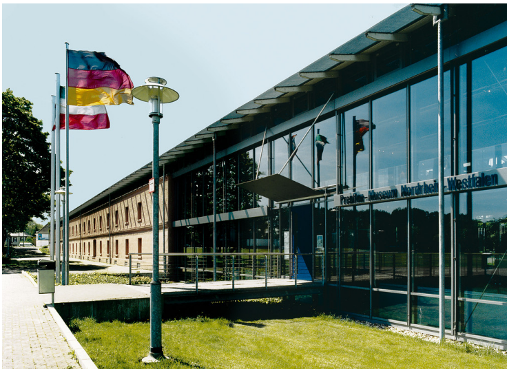
Außenansicht des Eingangsbereichs am Preußen-Museum in der ehemaligen Festungszitadelle Wesel. Fotograf/Urheber: Karsten Enderlein
