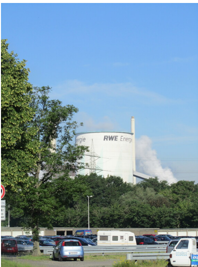
Kühlturm des Goldenberg-Werks in Knapsack (2014) Fotograf/Urheber: Nicole Schmitz
