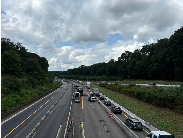
Bundesautobahn 4 (A4) mit Blick von der Autobahnbrücke bei Köln-Brück (2024) Fotograf/Urheber: Carolin Ehret
