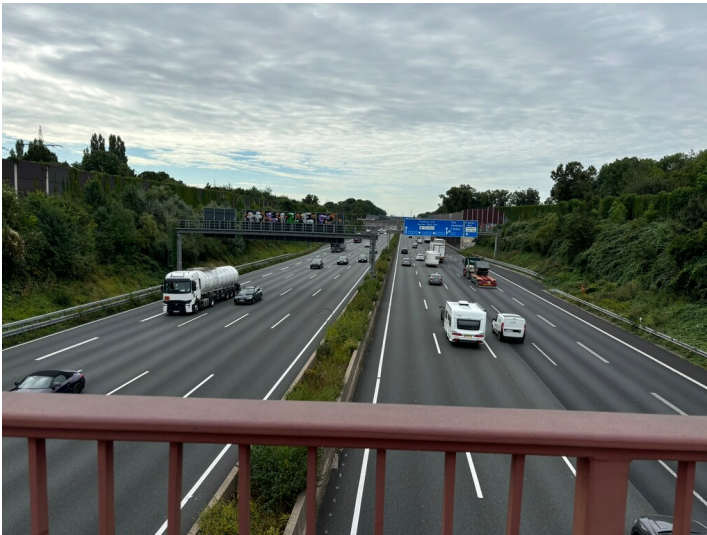
Bundesautobahn 3 (A 3) in Köln-Dellbrück (2024) Fotograf/Urheber: Carolin Ehret
