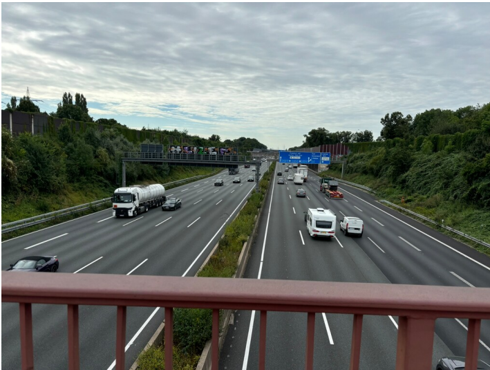
Bundesautobahn 3 (A 3) in Köln-Dellbrück (2024) Fotograf/Urheber: Carolin Ehret
