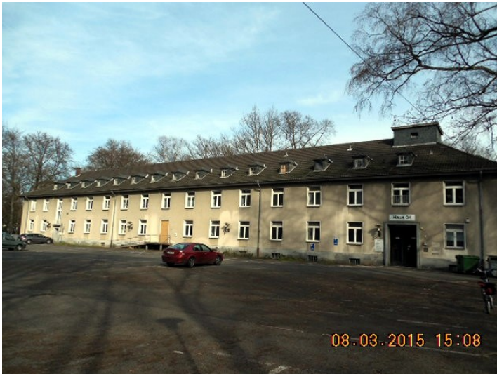
Ein Gebäude (ehemaliger Kasernenbau) des ehemaligen Militärflughafens Ostheim in Merheim mit Beobachtungsturm (2015) Fotograf/Urheber: Klaus-Dieter Kleefeld
