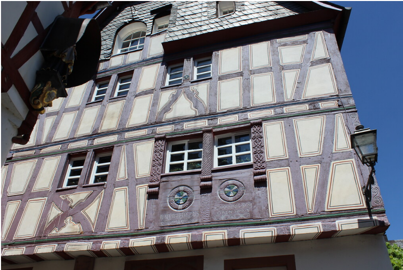
Fachwerkhaus Graf-Salm-Straße 5 in Briedel (2020) Fotograf/Urheber: Luisa Junker
