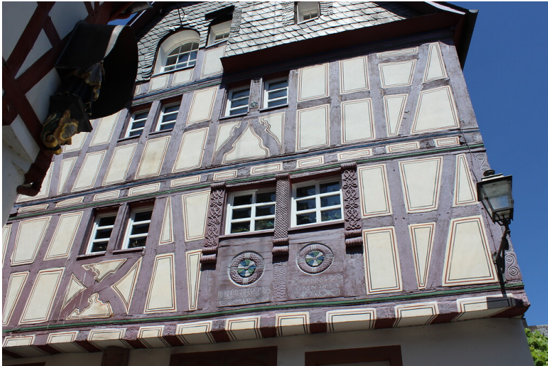
Fachwerkhaus Graf-Salm-Straße 5 in Briedel (2020) Fotograf/Urheber: Luisa Junker
