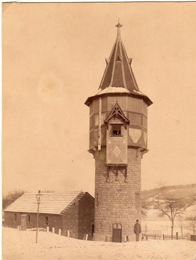
Historische Aufnahme: Der Wasserturm im Bahnhof in Münstereifel um 1910. Fotograf/Urheber: Unbekannt
