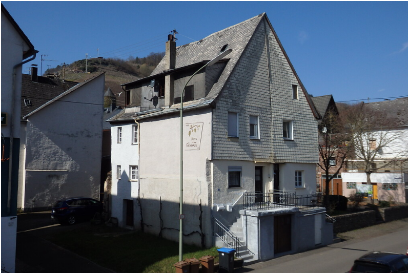
Blick auf das Doppelhaus Moselstraße 28/29 in Briedel (2020) Fotograf/Urheber: Hermann Thur
