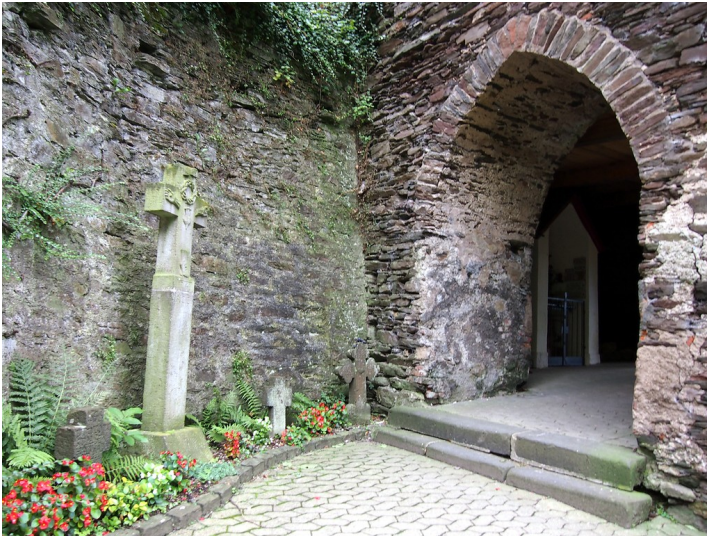
Zugang zum Viereckigen Turm in Zell an der Mosel (2015) Fotograf/Urheber: Jonas Breithaupt
