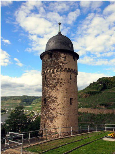
Ansicht des Pulverturms in Zell an der Mosel (2015) Fotograf/Urheber: Jonas Breithaupt
