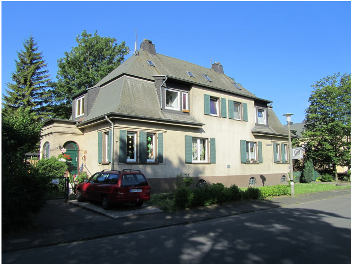
Doppelhaus in der Dr.-Krauß-Straße (2014) Fotograf/Urheber: Nicole Schmitz
