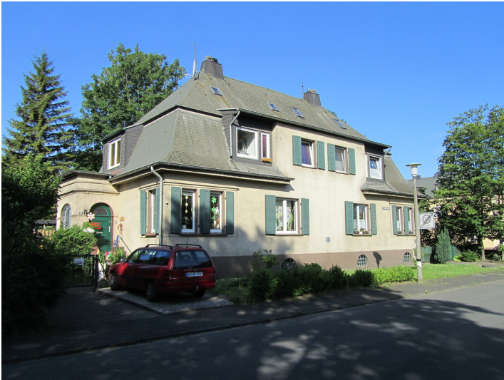
Doppelhaus in der Dr.-Krauß-Straße (2014) Fotograf/Urheber: Nicole Schmitz
