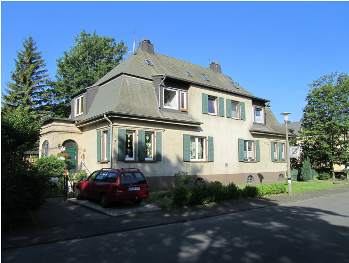
Doppelhaus in der Dr.-Krauß-Straße (2014) Fotograf/Urheber: Nicole Schmitz
