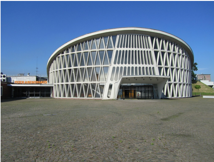
Eingangsseite des Feierabendhauses in Knapsack (2014) Fotograf/Urheber: Nicole Schmitz
