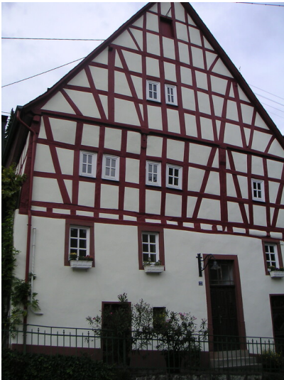
Fachwerkhaus Hauptstraße 77 in Briedel (2005) Fotograf/Urheber: Hermann Thur
