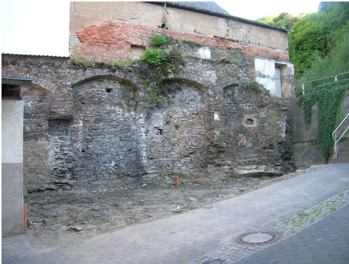
Briedeler Ringmauer (2006) Fotograf/Urheber: Wilfried Schiefer
