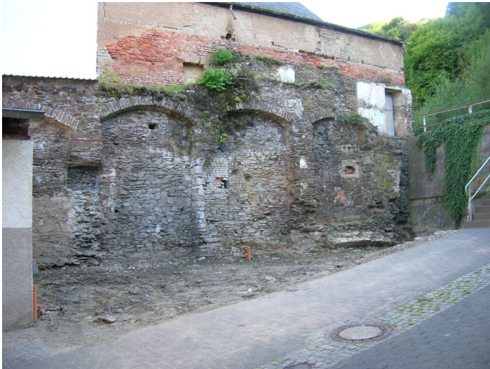
Briedeler Ringmauer (2006) Fotograf/Urheber: Wilfried Schiefer
