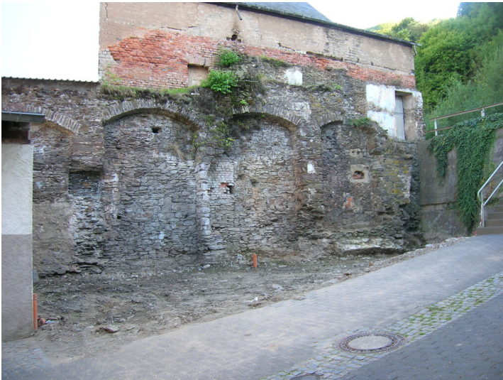
Briedeler Ringmauer (2006) Fotograf/Urheber: Wilfried Schiefer
